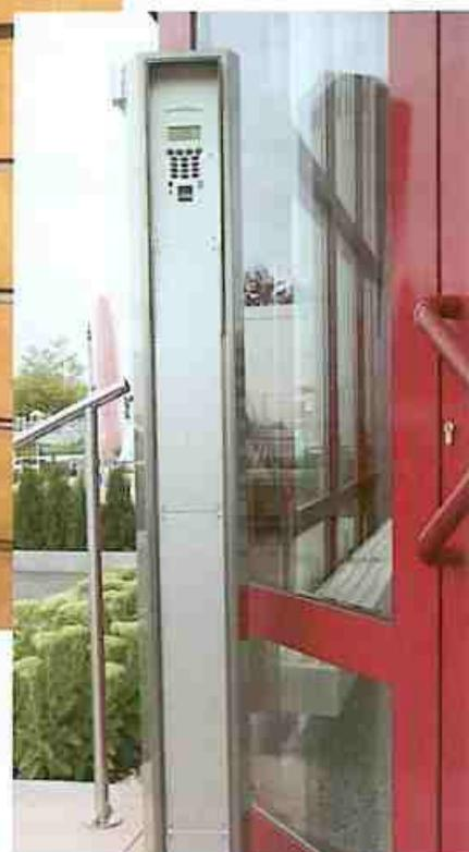
*Bild 2: Terminal in einer Standsäule für den Außenbereich*
